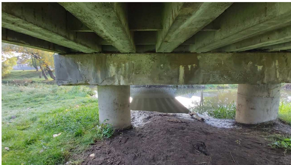
Obr. 26: Pohľad na stredový pilier – záclony, trhliny, pretekánie cez dilatačnú škáru, nánosy
