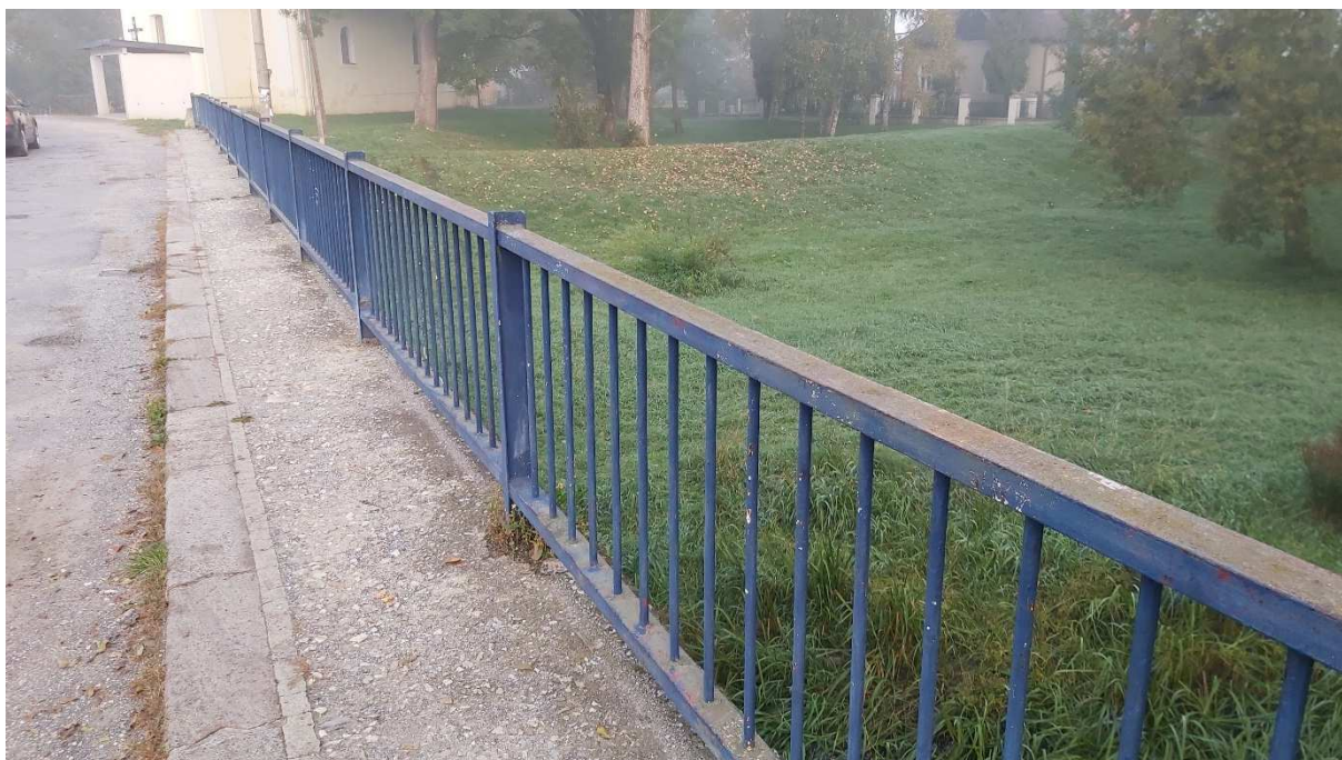
Obr. 31: Zábradlie na moste je v relatívne uspokojivom stave, potrebná obnova PKO
