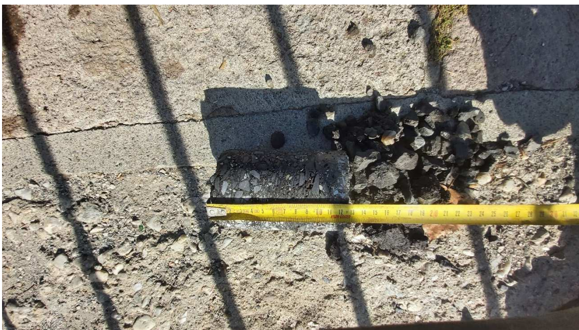
Obr. 84: Sonda pre overenie prítomnosti prechodových dosiek smer Holiša - pod 13 cm hrubou vrstvou asfaltobetónu už iba zhutnená štrková vrstva (overené do hĺbky 55 cm)
