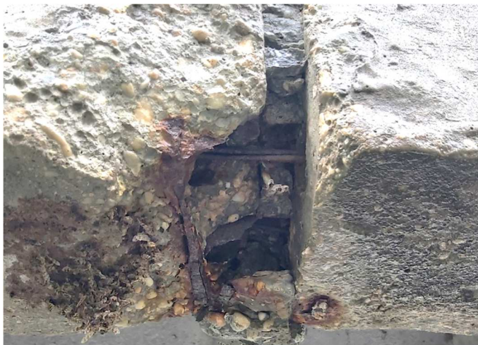
Obr. 21: Plne nefunkčný kábel a ostávajúce 2 drôty z druhého kábla v poli č. 2 smer Boľkovce, trvalé pretvorenie – pokles v styčnej škáre, začínajúce drvenie v tlakovej oblasti
