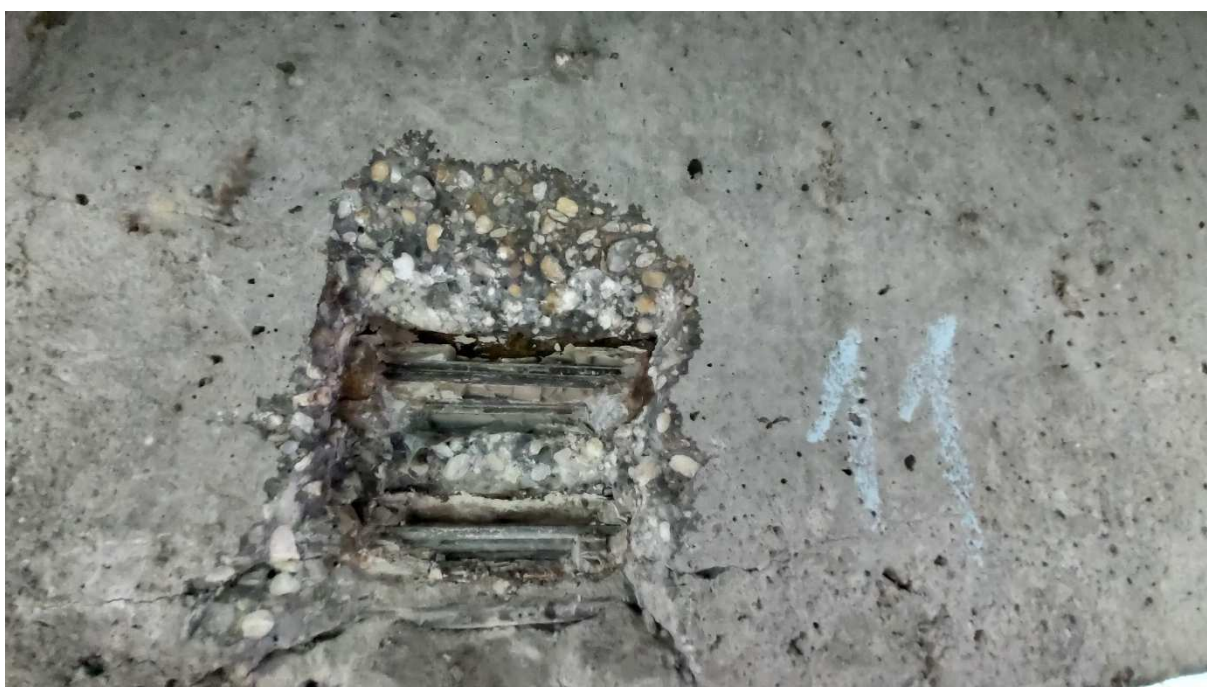
Obr. 74: Stav káblového kanálika a predpínacej výstuže, poloha P10 začínajúca rovnomerná korózia predpínacej výstuže
