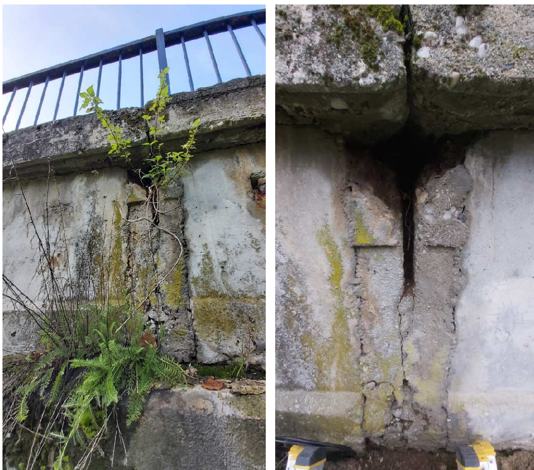
Obr. 6: Poškodenie v mieste dilatačných záverov mosta, zablokovanie dilatačnej škáry
