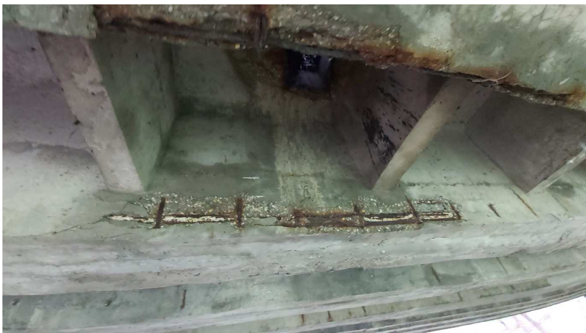
Obr. 12: Pohľad na miesta pri odvodňovačoch – rozpad betónu, chýbajúca krycia vrstva, odhalené a skorodované káblové kanáliky, pozdĺžne trhliny v mieste káblových kanálikov
