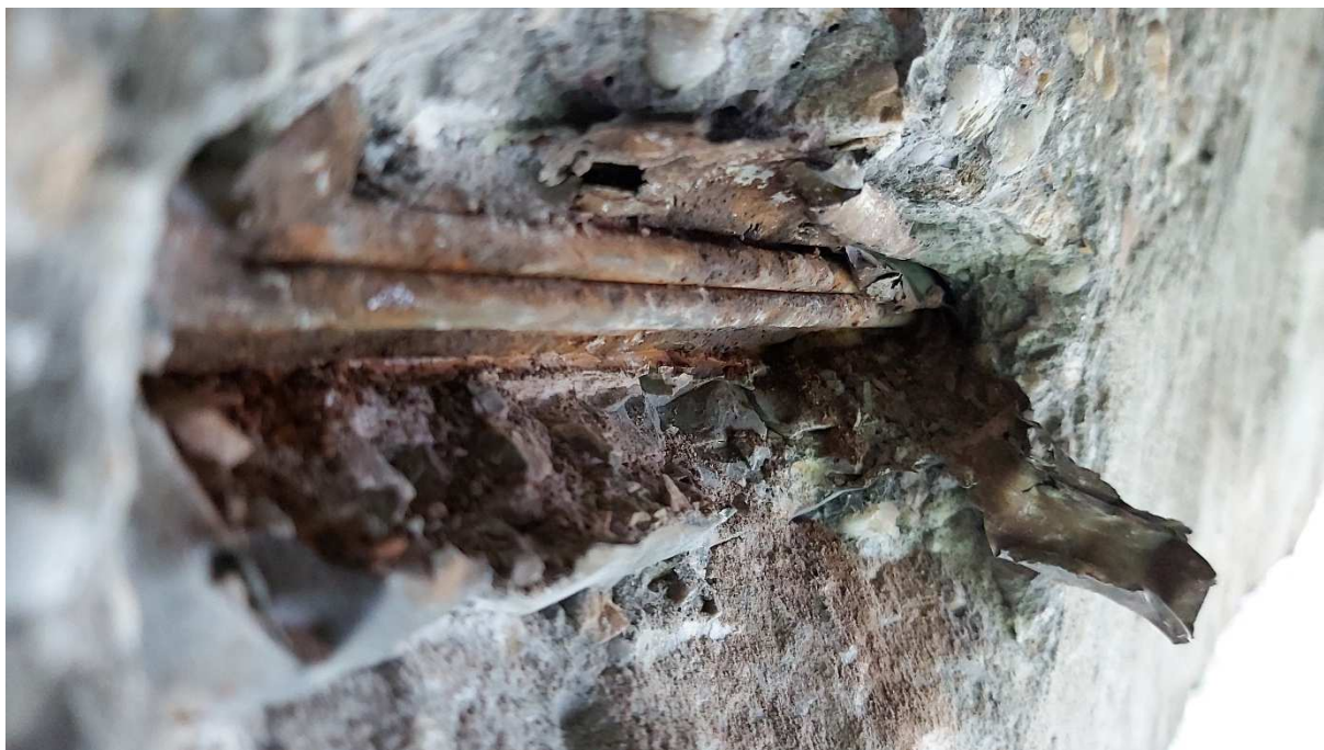
Obr. 65: Stav káblového kanálika a predpínacej výstuže P2– rovnomerná korózia, drôty sú voľné – niekde po dĺžke musia byť prerušené
