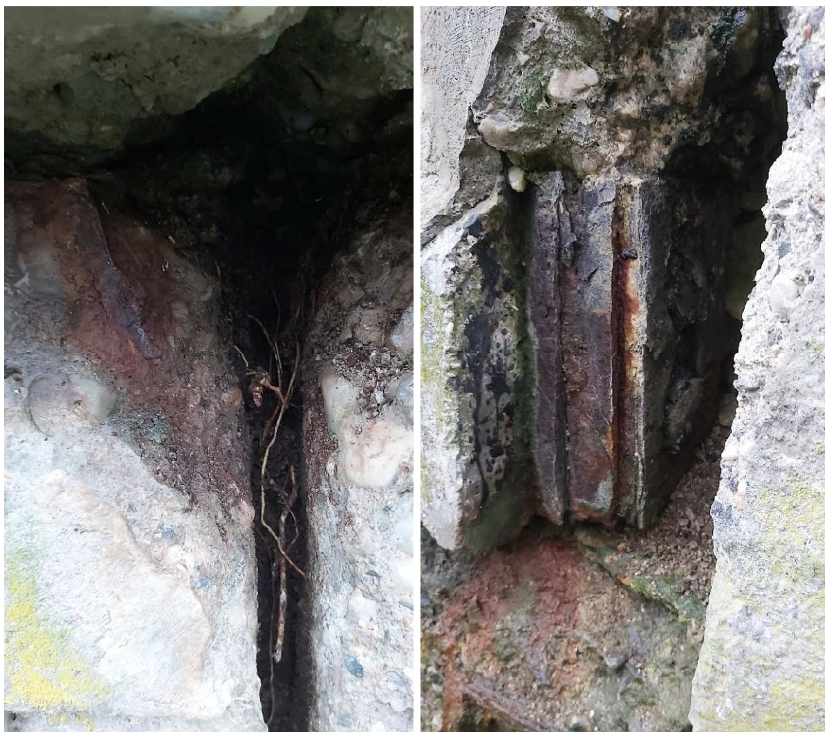
Obr. 80: Styčná škára a kotvy nad stredovým pilierom, pravdepodobné výrazné korózne poškodenia kotvy predpínacej výstuže
