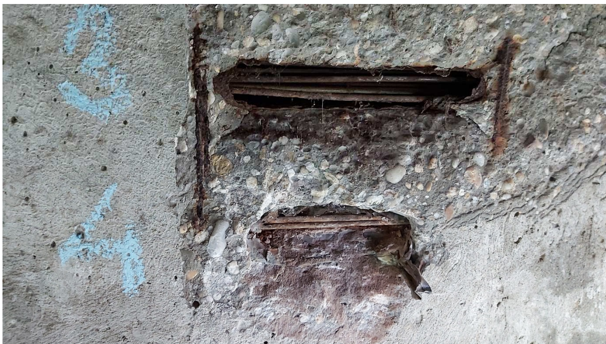
Obr. 66: Stav káblového kanálika a predpínacej výstuže, poloha P3 pri kotevnej oblasti, rovnomerná aj lokálna korózia predpínacej výstuže, väčší rozsah korózie ako pri oblasti v strede rozpätia – tri a päť drôtov bolo skorodovaných úplne.
