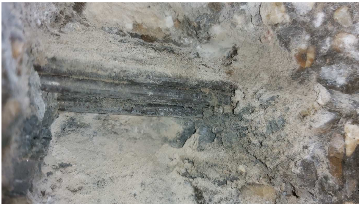
Obr. 76: Stav káblového kanálika a predpínacej výstuže priečneho zovretia P13, vnútorné nosníky v strede rozpätia
