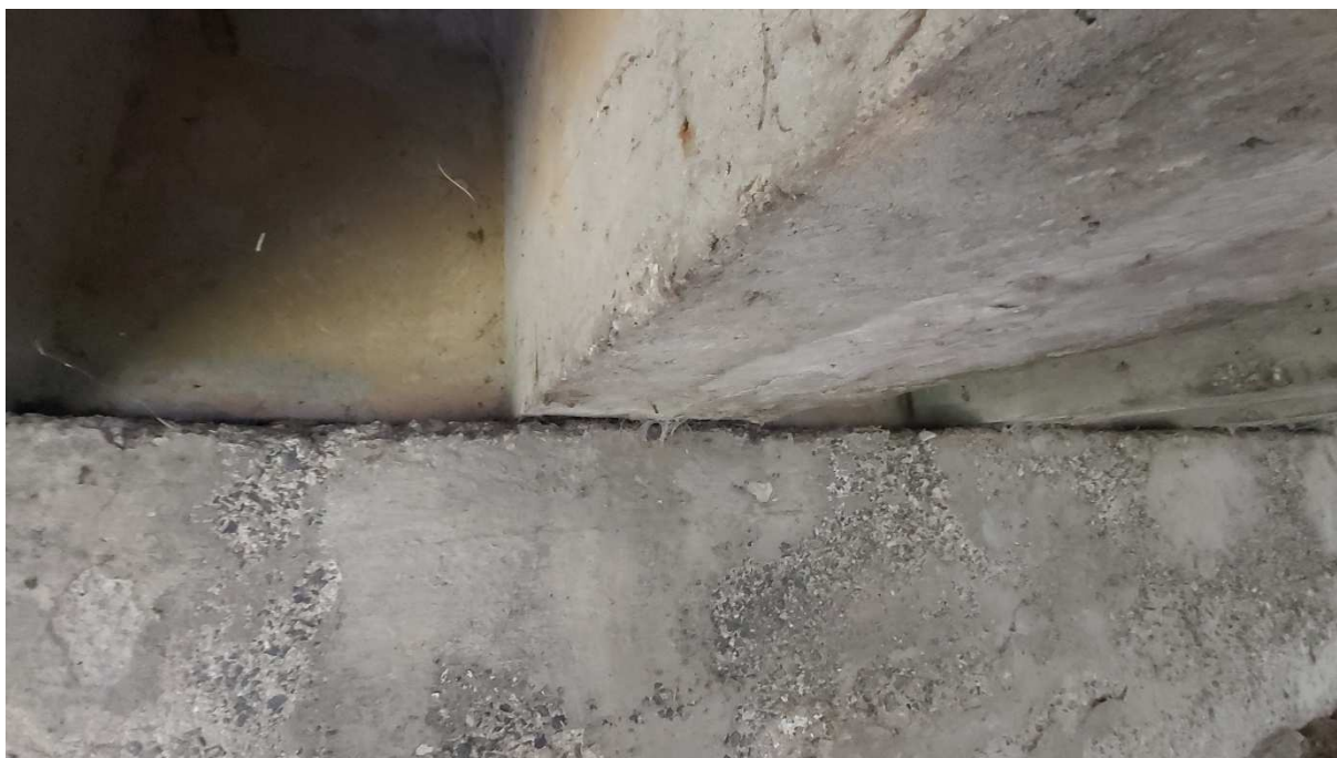
Obr. 29: Pohyblivé na opore – lepenka v exponovanej časti rozpadnutá
