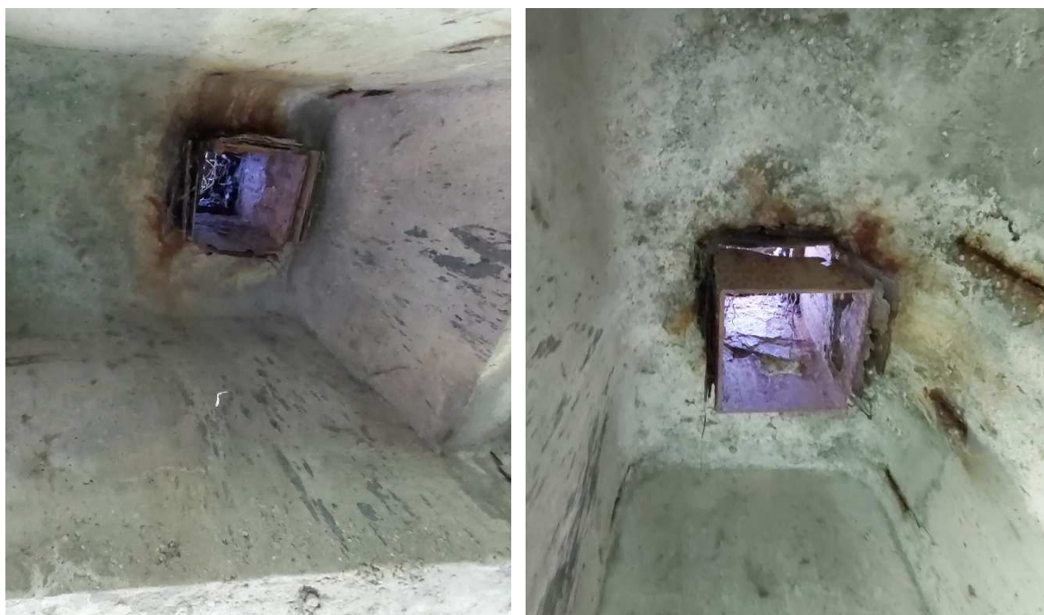
Obr. 5: Skorodované a prederavené /nefunkčné rúry odvodňovačov
