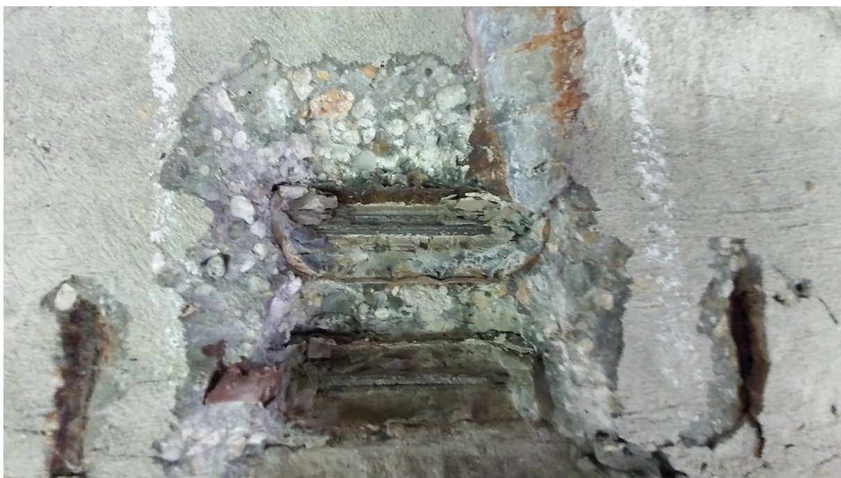
Obr. 73: Stav káblového kanálika a predpínacej výstuže, poloha P9,P10 začínajúca rovnomerná korózia predpínacej výstuže
