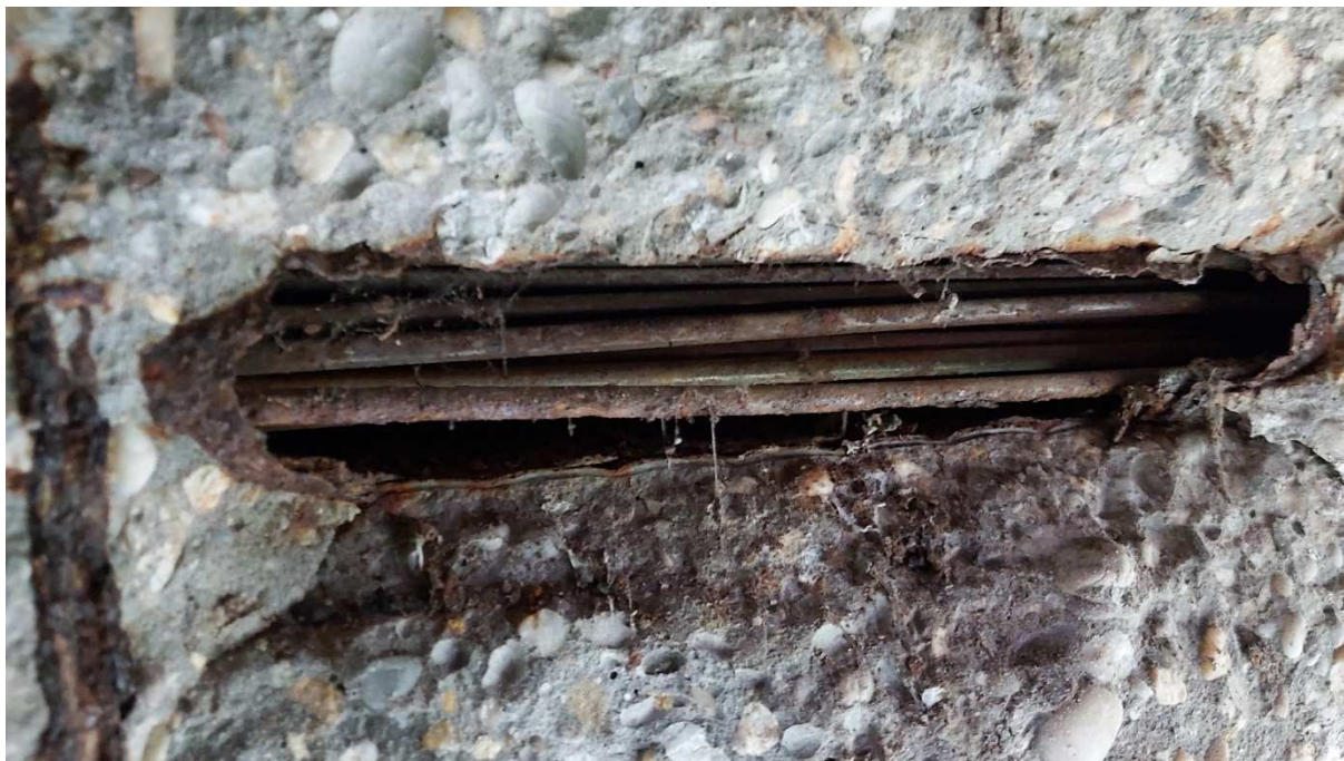
Obr. 64: Stav káblového kanálika a predpínacej výstuže P1– rovnomerná korózia, drôty sú voľné – niekde po dĺžke musia byť prerušené
