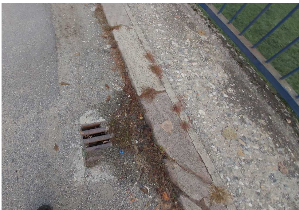
Obr. 4: Čiastočne funkčný odvodňovač
