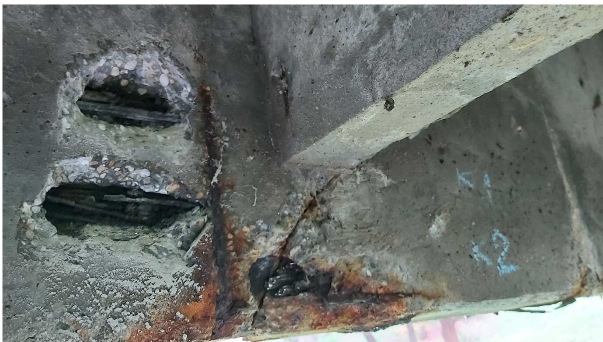
Obr. 71: Stav káblového kanálika a predpínacej výstuže, poloha K1,K2 rovnomerná korózia predpínacej výstuže, prerušená výstuž vo všetkých troch polohách po výške prierezu
