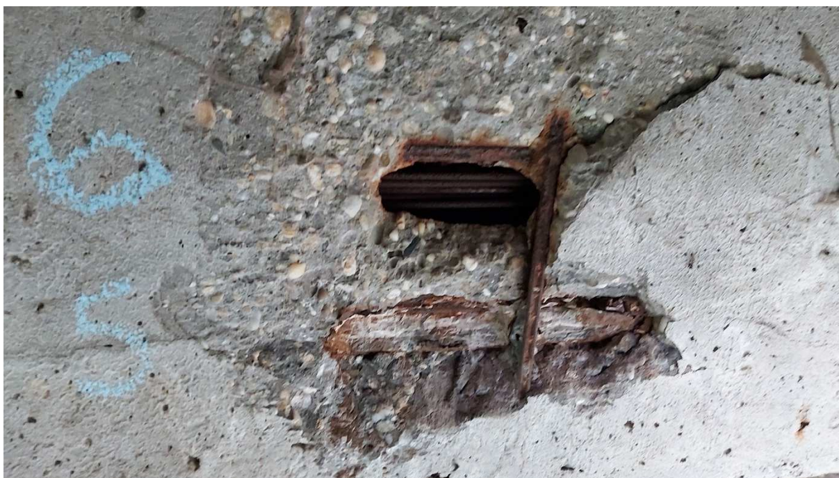
Obr. 67: Stav káblového kanálika a predpínacej výstuže, poloha P5 a P6 rovnomerná korózia predpínacej výstuže, zainjektovaný neúplne iba spodný kábel P5
