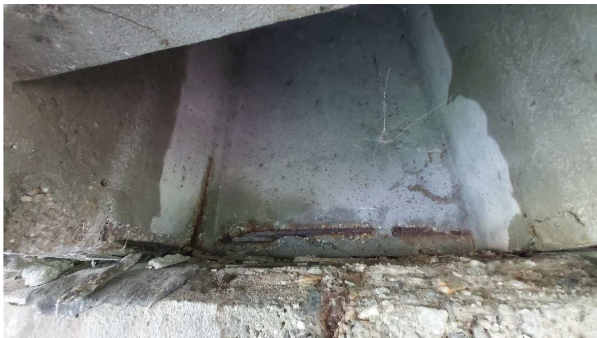
Obr. 8: Zatekanie na stredovom pilieri cez mostný záver , uloženie - vrstva lepenky rozpadnutá
