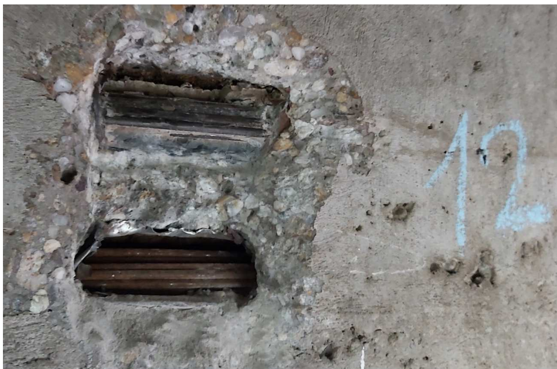
Obr. 75: Stav káblového kanálika a predpínacej výstuže, poloha P12 rovnomerná korózia predpínacej výstuže, neúplné zainjektovanie káblového kanálika
