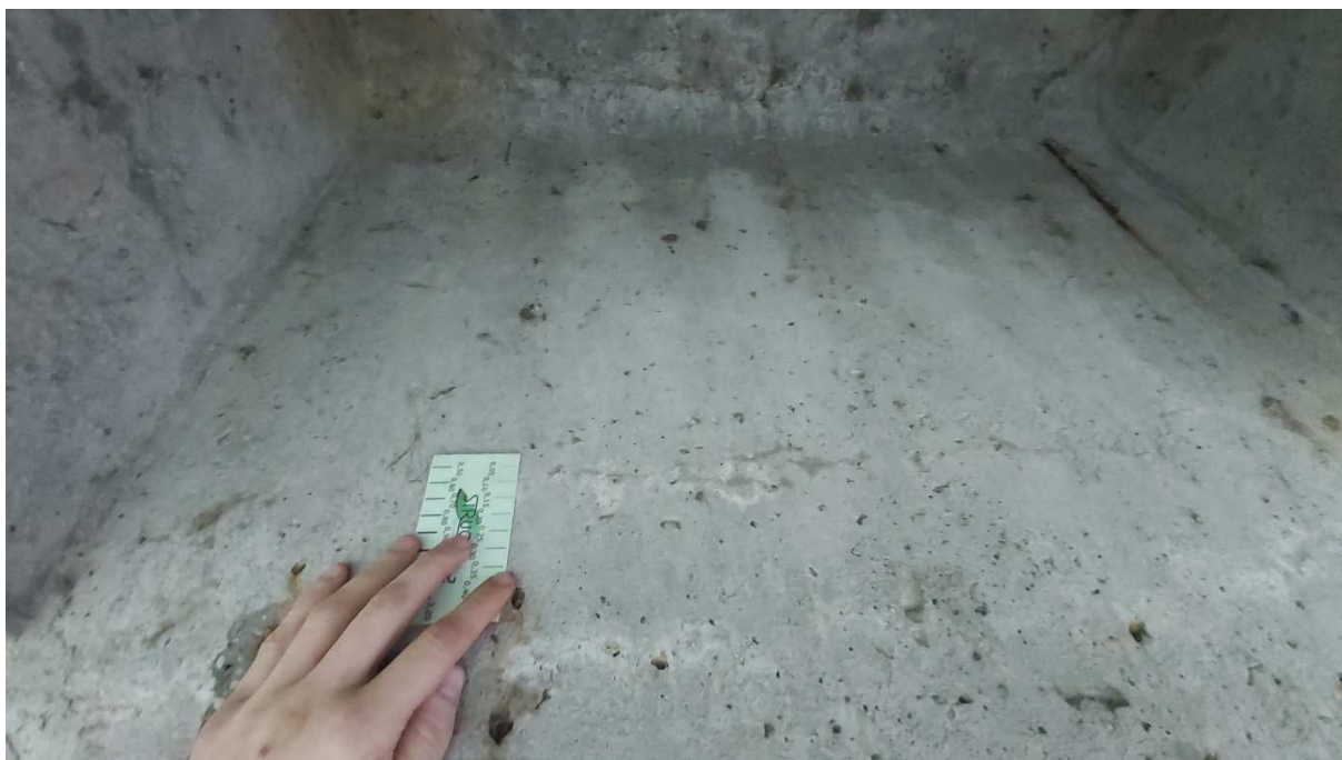
Obr. 15: Viac ako 50 % plochy nosníkov pozdĺžne trhliny a výkvety pri káblových kanálikoch, trhliny merané šírky 0,10 – 0,25mm (väčšie šírky samostatne opísané poruchy)
