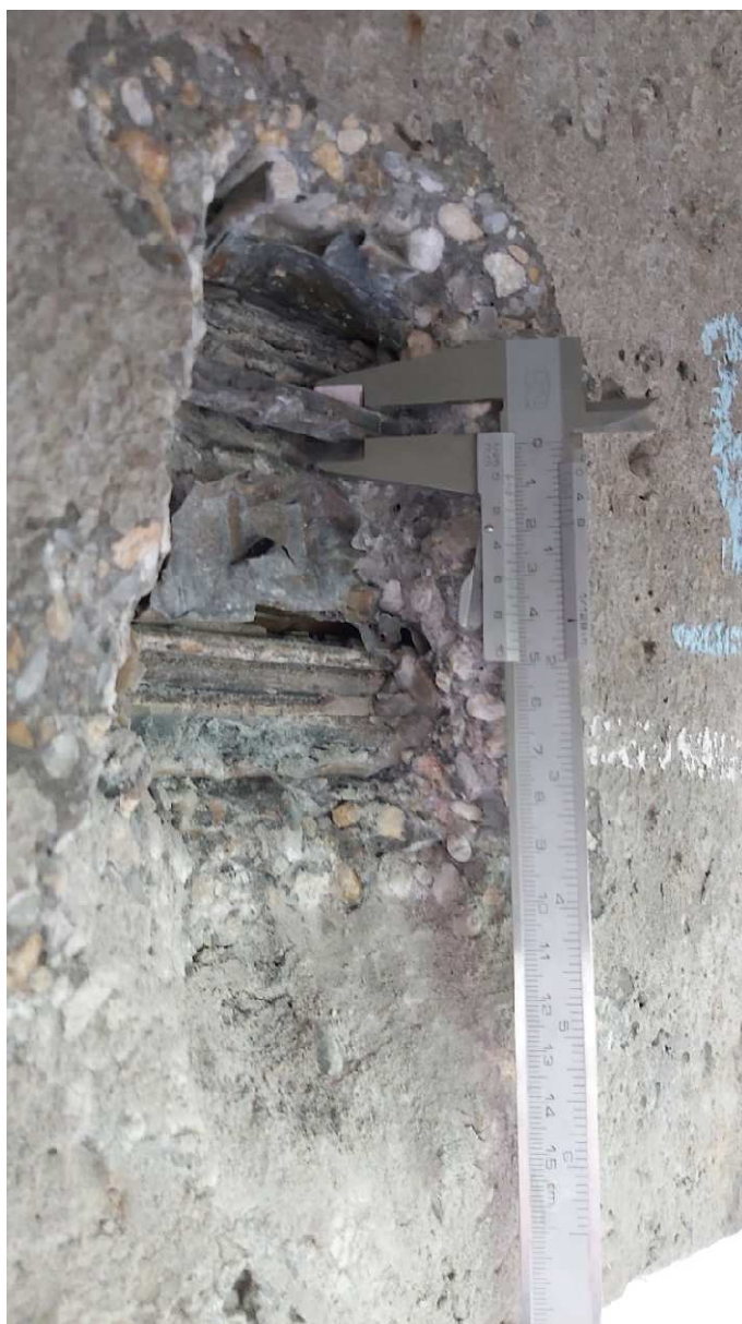
Obr. 70: Stav káblového kanálika a predpínacej výstuže, poloha P7 a P8 rovnomerná korózia predpínacej výstuže, zainjektovanie káblového kanálika
