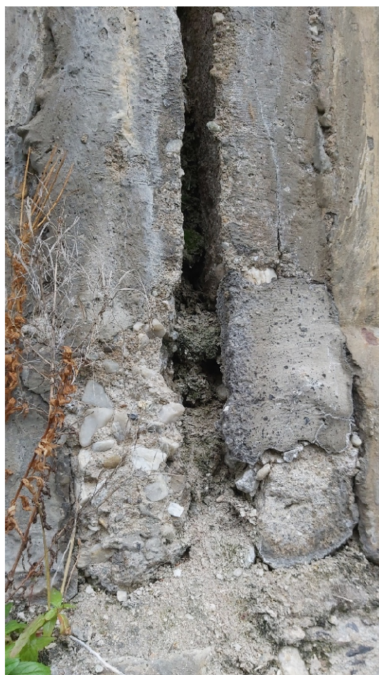
Obr. 7: Zablokovanie dilatačnej škáry
