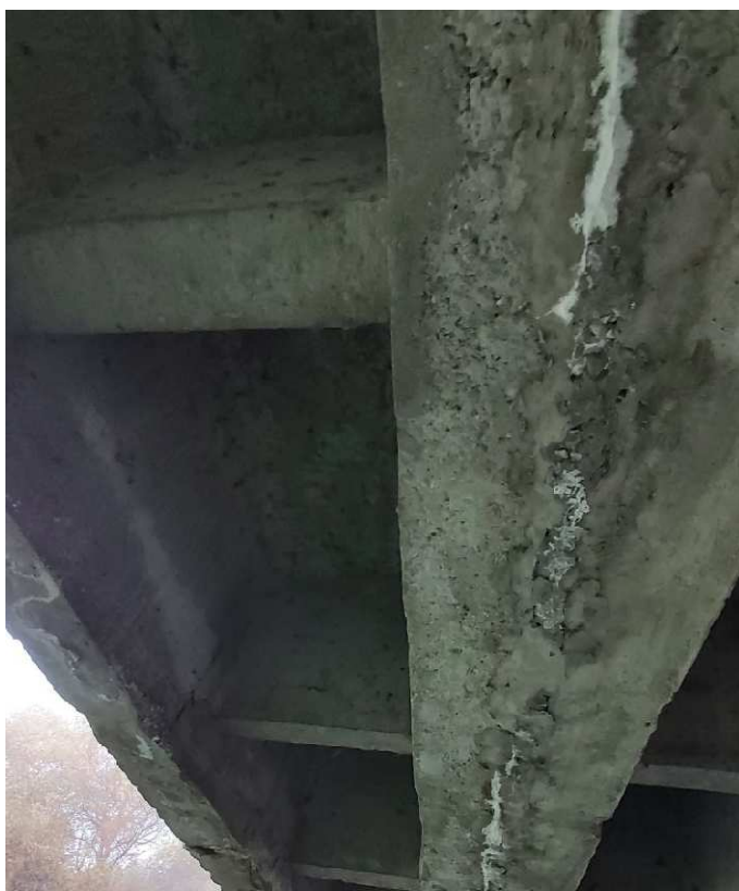
Obr. 19: výluhy a inkrustácie v mieste škár nosníkov, zatekanie cez styčné škáry
