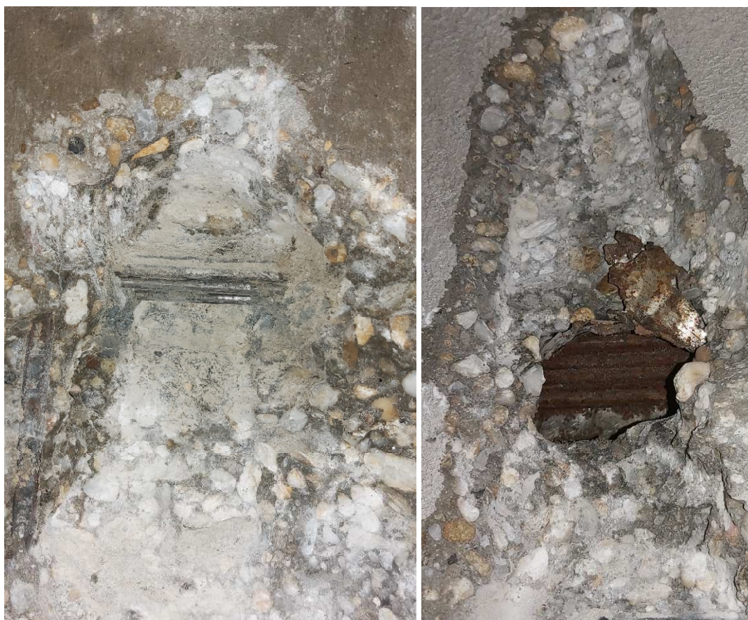
Obr. 77: Stav káblového kanálika a predpínacej výstuže, poloha P14 pri podpere rovnomerná korózia predpínacej výstuže, neúplné zainjektovanie káblového kanálika / žiadna injektáž už pri podpere
