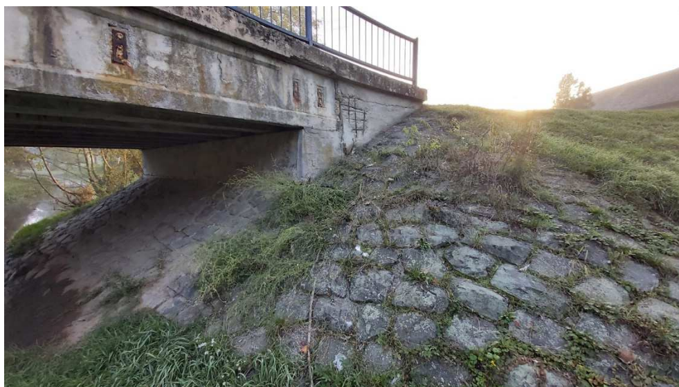
Obr. 25: Pohľad na oporu č. 3 (smer Boľkovce) – vykazuje veľmi dobrý, upadnutá spevnená časť násypu pred oporou, náletová vegetácia v blízkosti opory
