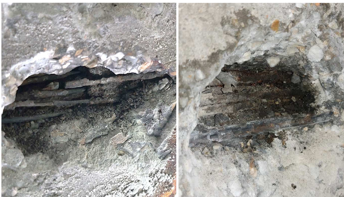
Obr. 72: Stav káblového kanálika a predpínacej výstuže, poloha K1 vľavo a K2 vpravo rovnomerná korózia predpínacej výstuže, nedokonalé zainjektovanie káblového kanálika, úplne prerušená výstuž
