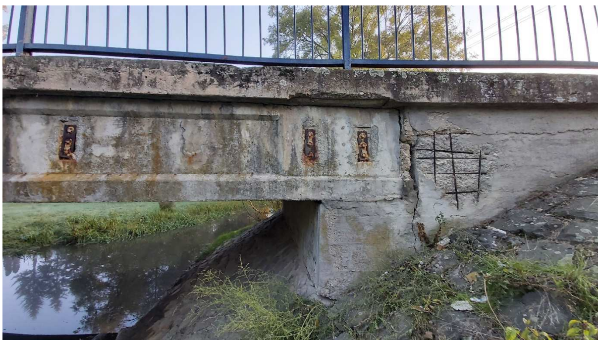
Obr. 63: Kotvy priečného predopnutia – plne skorodované
