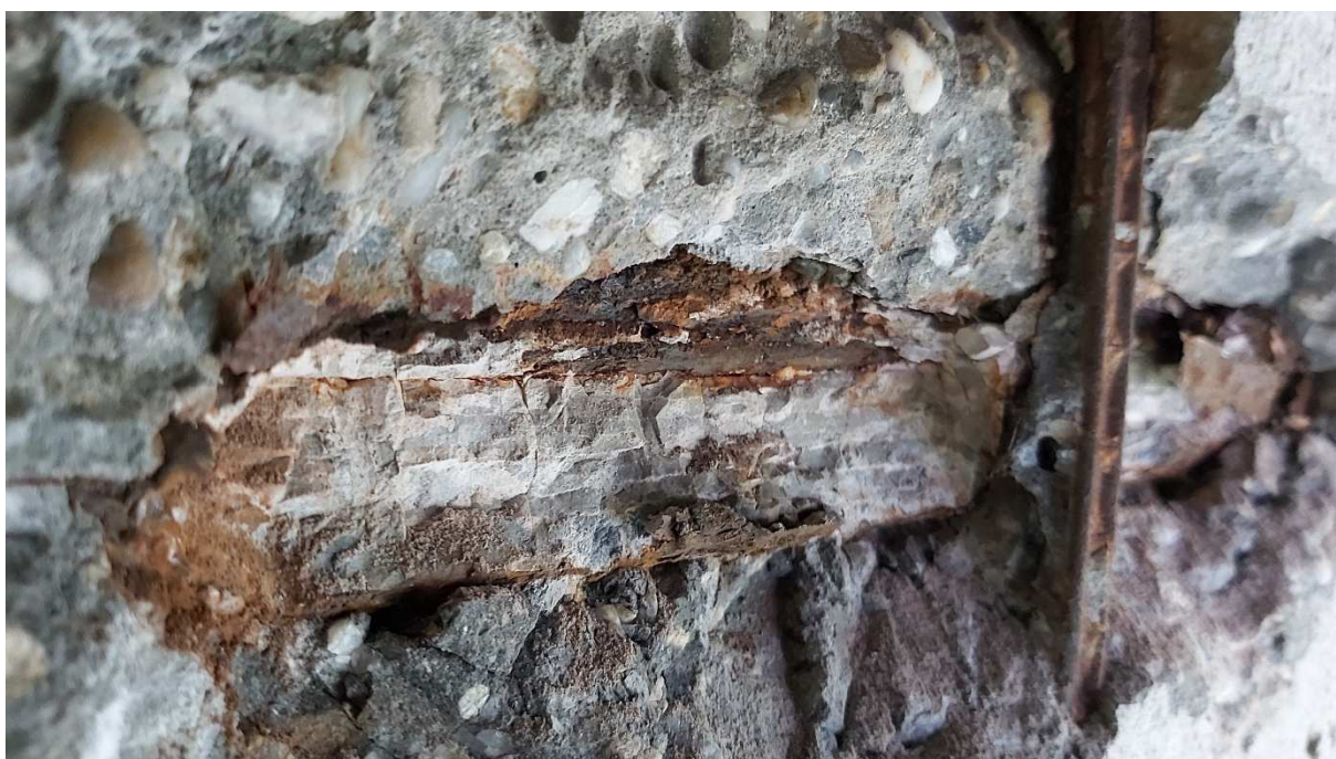
Obr. 69: Stav káblového kanálika a predpínacej výstuže, poloha P5 rovnomerná korózia predpínacej výstuže, neúplné zainjektovanie káblového kanálika
