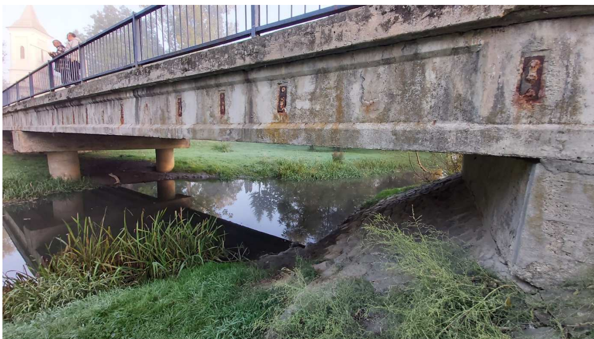
Obr. 36: Spevnenie koryta zanesené bahnom, rozpadnuté najmä na strane pri stredovom pilieri
