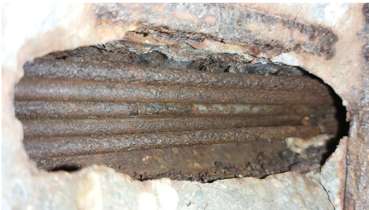
Obr. 68: Stav káblového kanálika a predpínacej výstuže, poloha P6 pri kotevnej oblasti, rovnomerná korózia predpínacej výstuže
