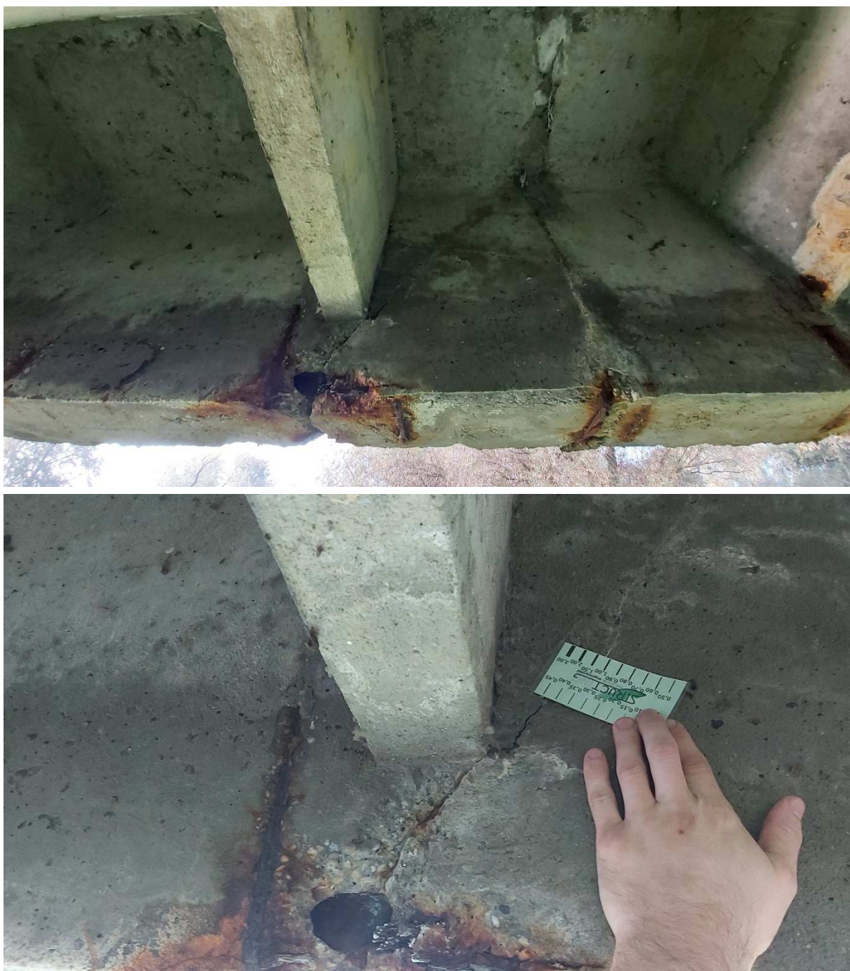
Obr. 16: Plne nefunkčný káblový kanálik a plne skorodovaná predpínacia výstuž v poli č. 1 smer Holiša, šikmá trhlina šírky až do 1,5 mm, zaklínenie a začínajúce drvenie v tlakovej oblasti – v prípade väčšieho zaťaženia hrozí kolaps vplyvom náhleho porušenia betónu
