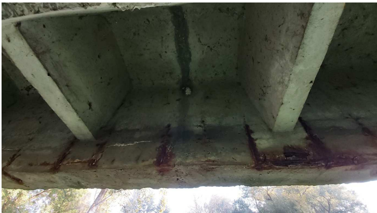
Obr. 13: Pohľad na koróziu výstuže na krajných prefabrikátoch, pretekajúce cez vozovku
