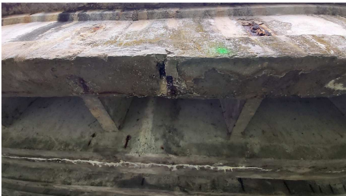
Obr. 18: výluhy a inkrustácie v mieste škár nosníkov, trhliny a výluhy na káblových kanálikoch
