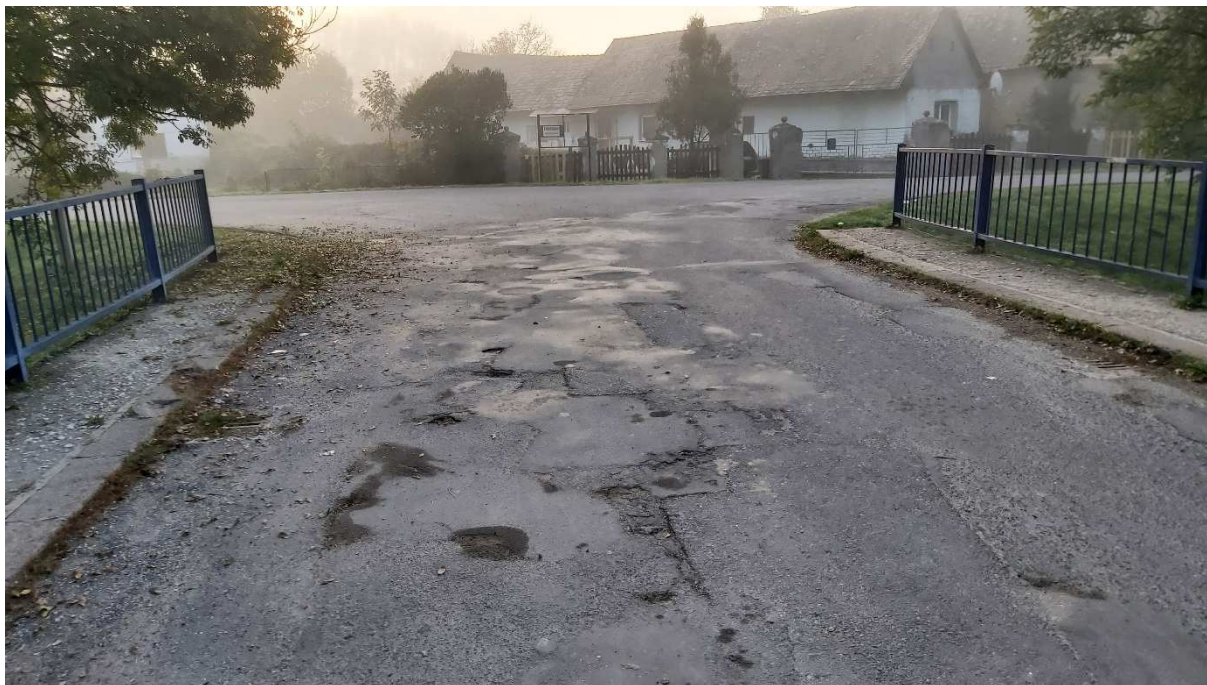
Obr. 1: Stav vozovky na moste – preliačiny, rozpad vozovky, priečne trhliny, predošlé lokálne opravy s výmoľmi, obrušovanie povrchu vozovky
