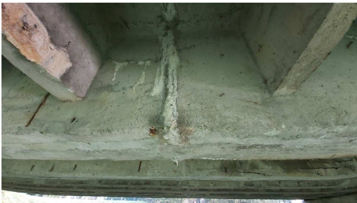
Obr. 17: výluhy a inkrustácie v mieste škár nosníkov, trhliny a výluhy na káblových kanálikoch
