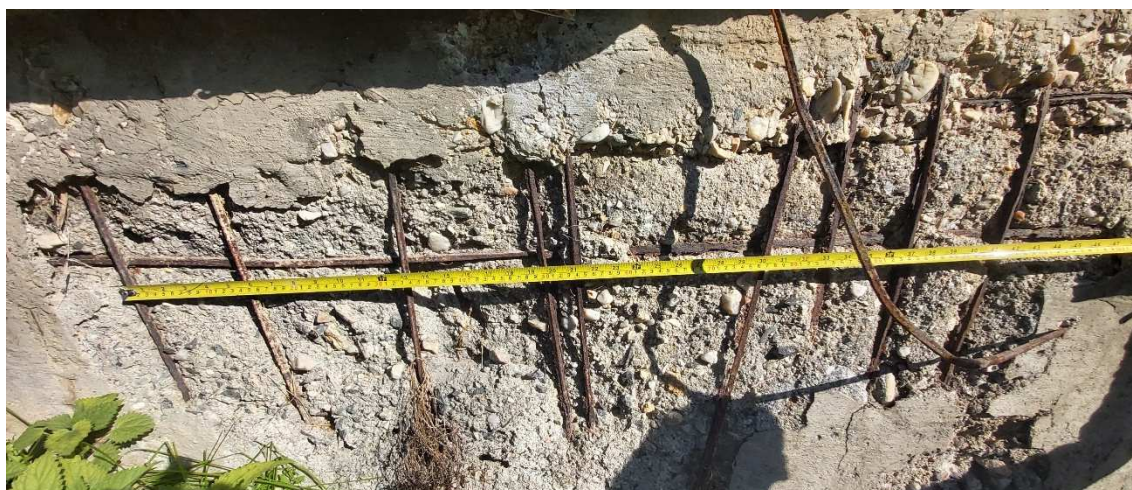
Obr. 24: Rozpad krycej vrstvy krídla, obnažená skorodovaná výstuž krídla
