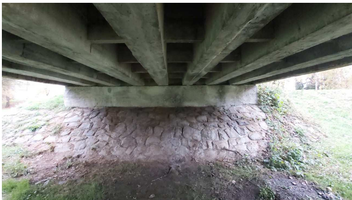
Obr. 23: Pohľad na oporu 1 (smer Holiša) – rozpad krycej vrstvy betónu, mierne trhliny na povrchu do šírky 0,2 mm, upadnutie vrcholu spevnenej časti násypu
