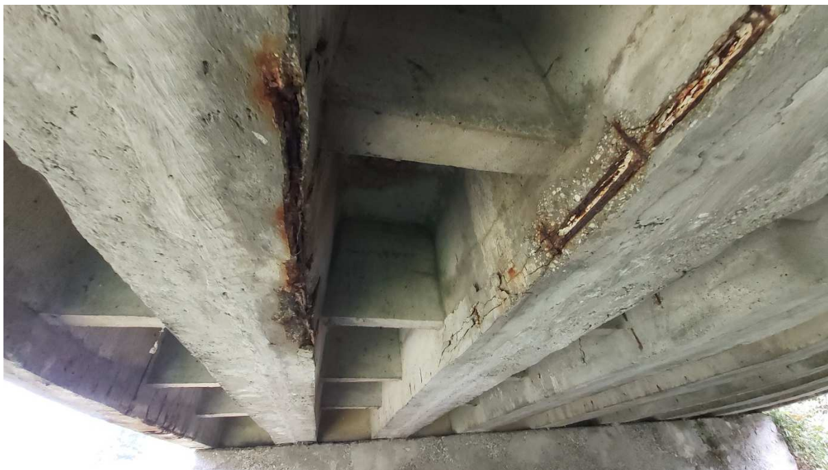
Obr. 11: Pohľad na miesta pri odvodňovačoch – rozpad betónu, chýbajúca krycia vrstva, odhalené a skorodované káblové kanáliky, pozdĺžne trhliny v mieste káblových kanálikov
