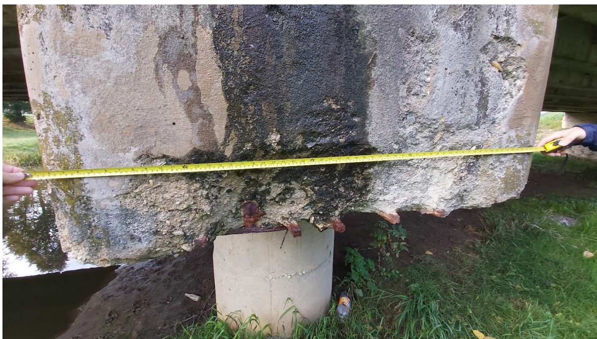
Obr. 48: Pozdĺžna výstuž úložného prahu piliera
