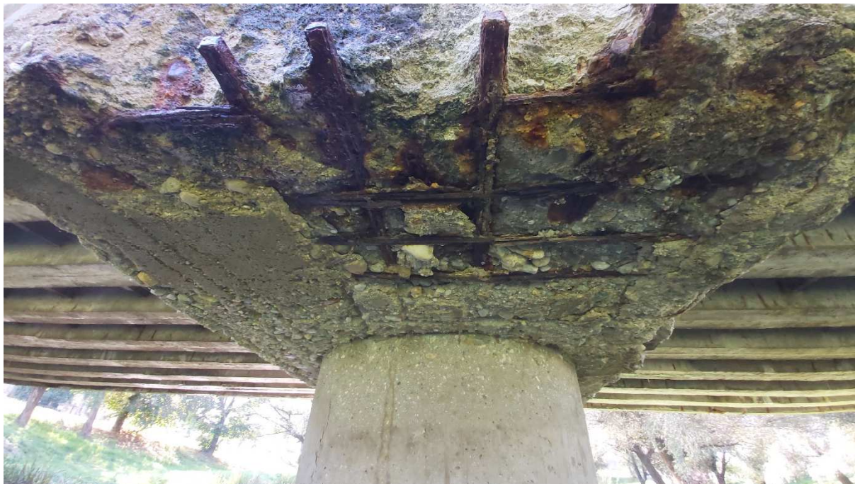
Obr. 27: Pohľad na stredový pilier– porušenie presahujúcich okrajov úložných prahov
