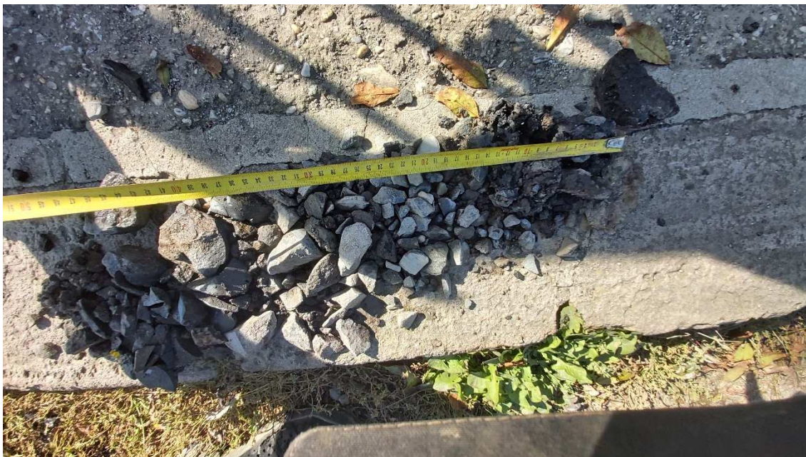
Obr. 83: Sonda pre overenie prítomnosti prechodových dosiek smer Boľkovce - pod 15 cm hrubou vrstvou asfaltobetónu už iba zhutnená štrková vrstva (overené do hĺbky 60 cm)
