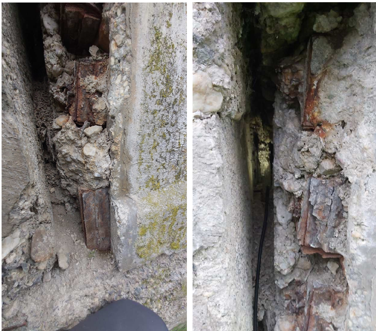
Obr. 78: Koniec mosta pri závernej stienke (vľavo), pravdepodobné výrazné korózne poškodenia kotvy predpínacej výstuže
