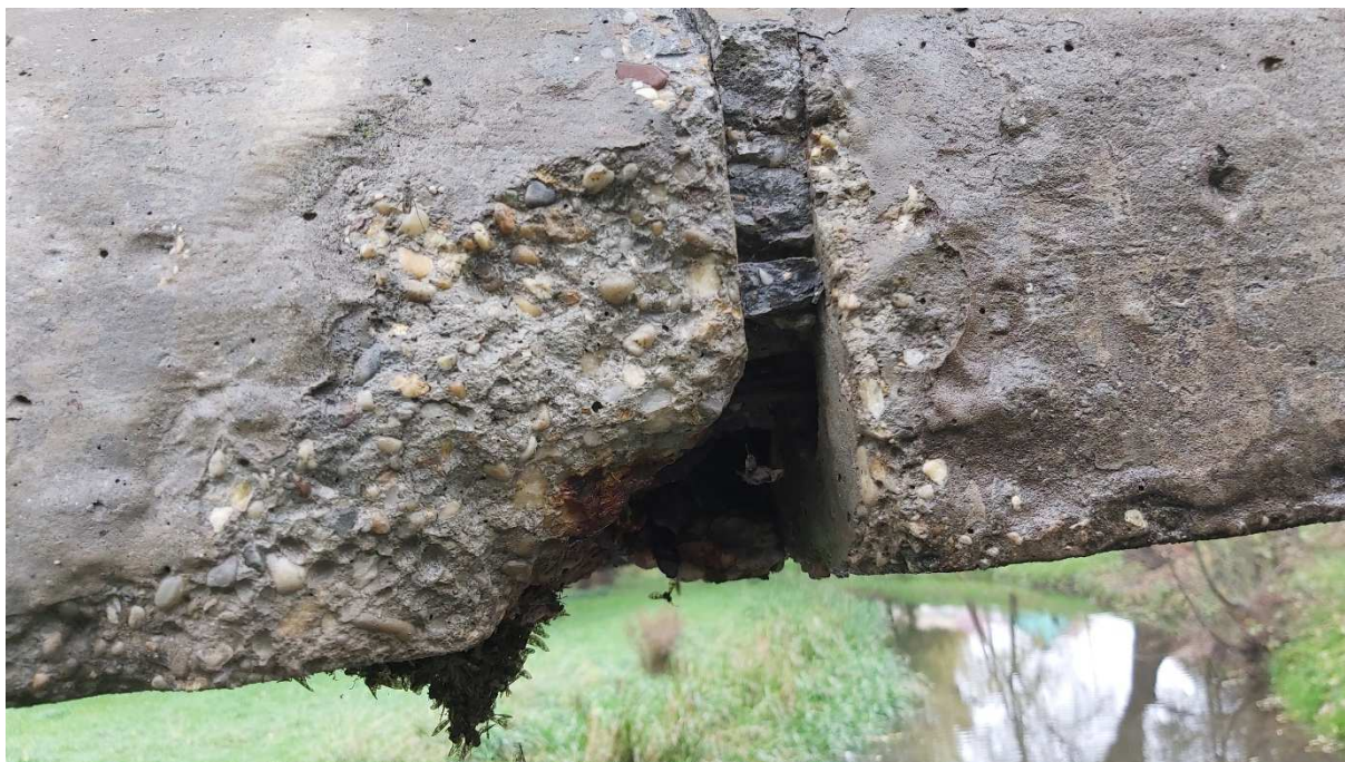
Obr. 20: Plne nefunkčný kábel a ostávajúce 2 drôty z druhého kábla v poli č. 2 smer Boľkovce, trvalé pretvorenie – pokles v styčnej škáre, začínajúce drvenie v tlakovej oblasti
